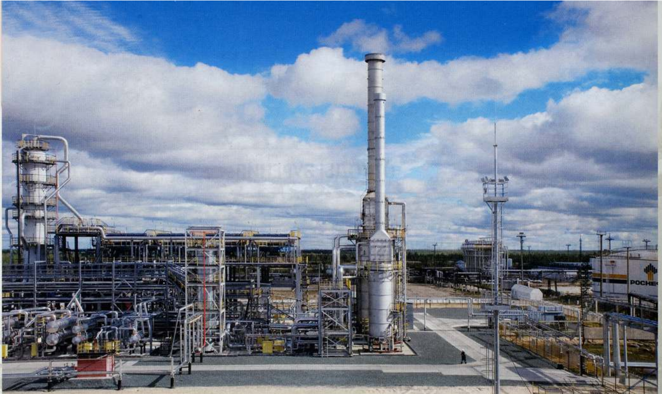
Установка стабилизации и очистки конденсата Тарасовского МР
