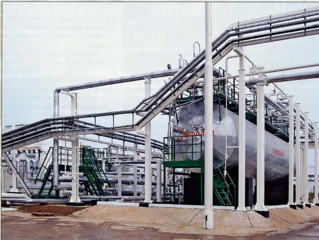
Многофункциональный аппарат. УППНГ на НСП <РОМАНОВО>
